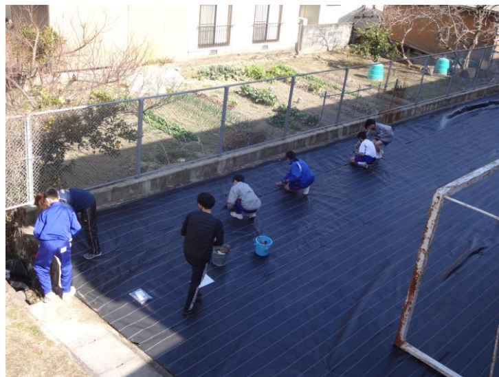
体育館横に防草シートを設置
